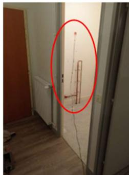
FIGURE 25 : FLUXMETRE INSTALLE A PROXIMITE D'UNE CANALISATION (A PRIORI FROIDE) S'ETANT AVERE ETRE UN BOUCLAGE D'ECS NON CALORIFUGE
